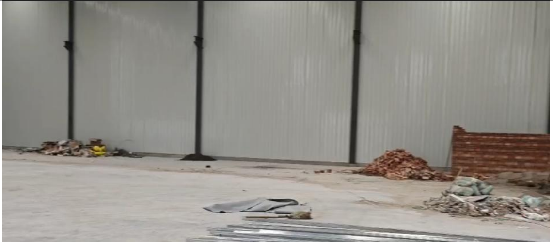
购买厂房现状
