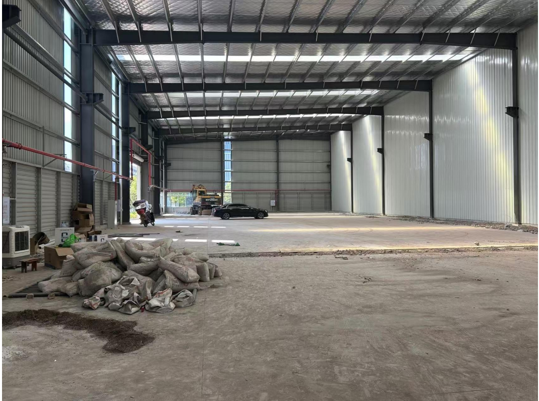
购买厂房现状
