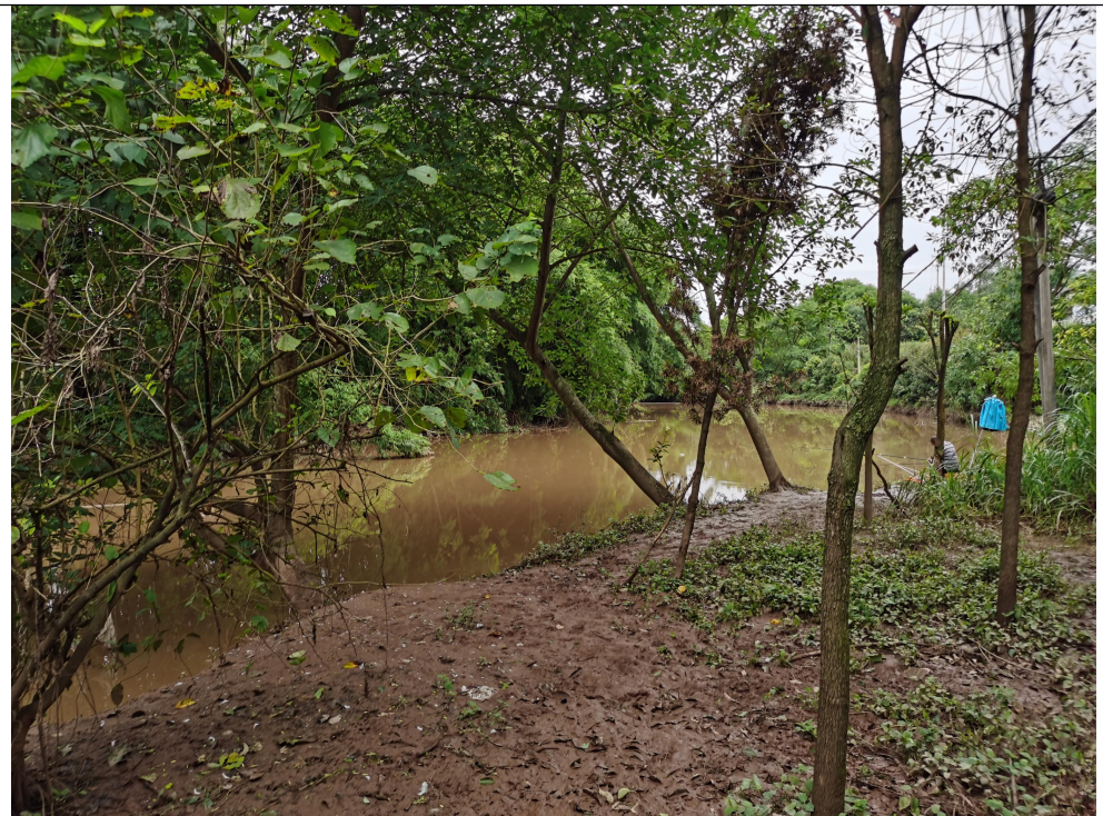
桩号 K13+260~K14+560 段渔溪河现状图
