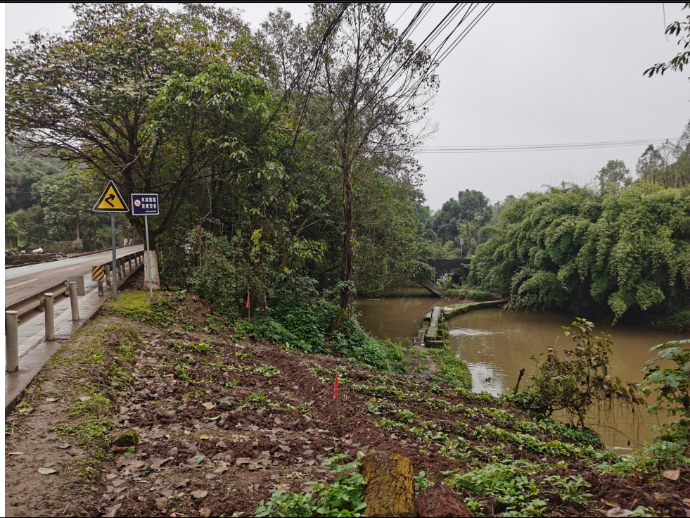
桩号 K13+260~K14+560 段渔溪河现状图
